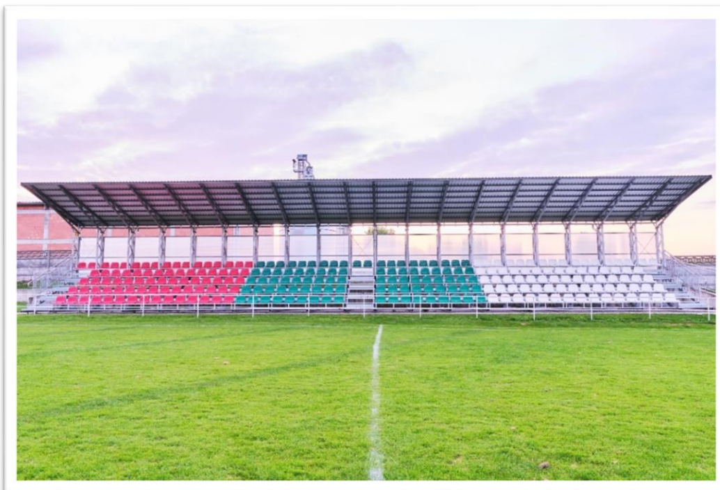
Rycina 4. Obiekt sportowo-rekreacyjno-turystyczny przy ul. Sportowej 9 w Polance Wielkiej. Źródło: IRMiR
